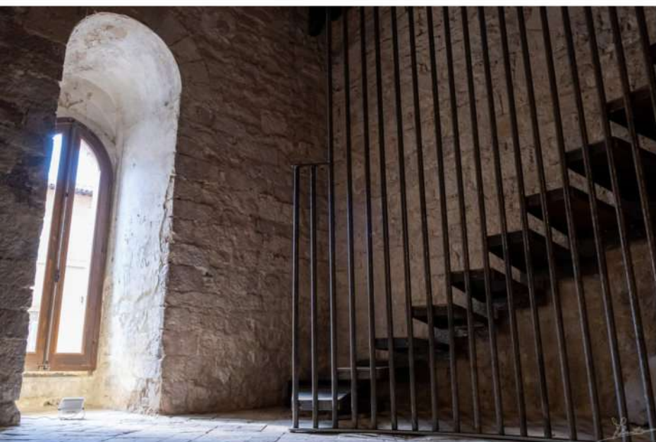
Scala della Torre post intervento e vista
