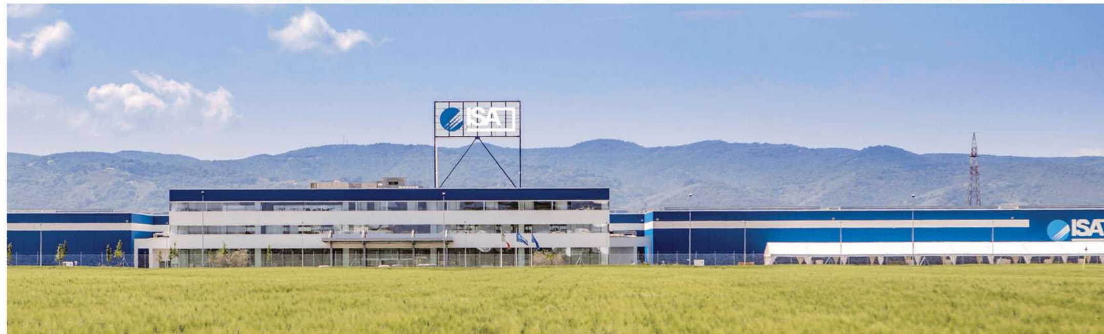
Nuovo Stabilimento realizzato
