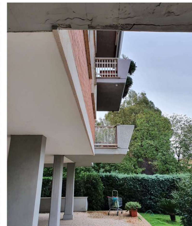
Condominio Cerveteri ex ante intervento
