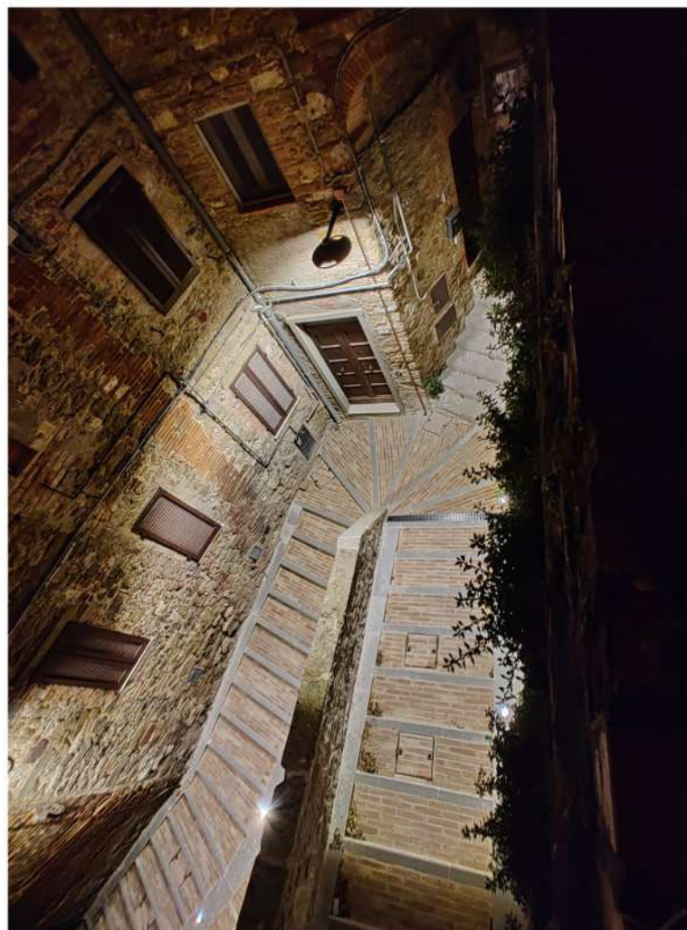
Scala di San Bernardino post intervento
