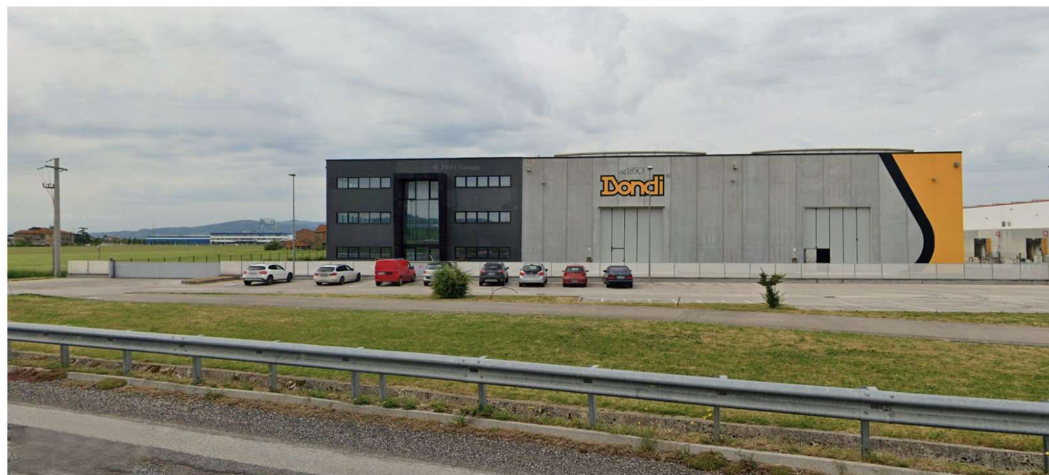
Nuovo Stabilimento realizzato
