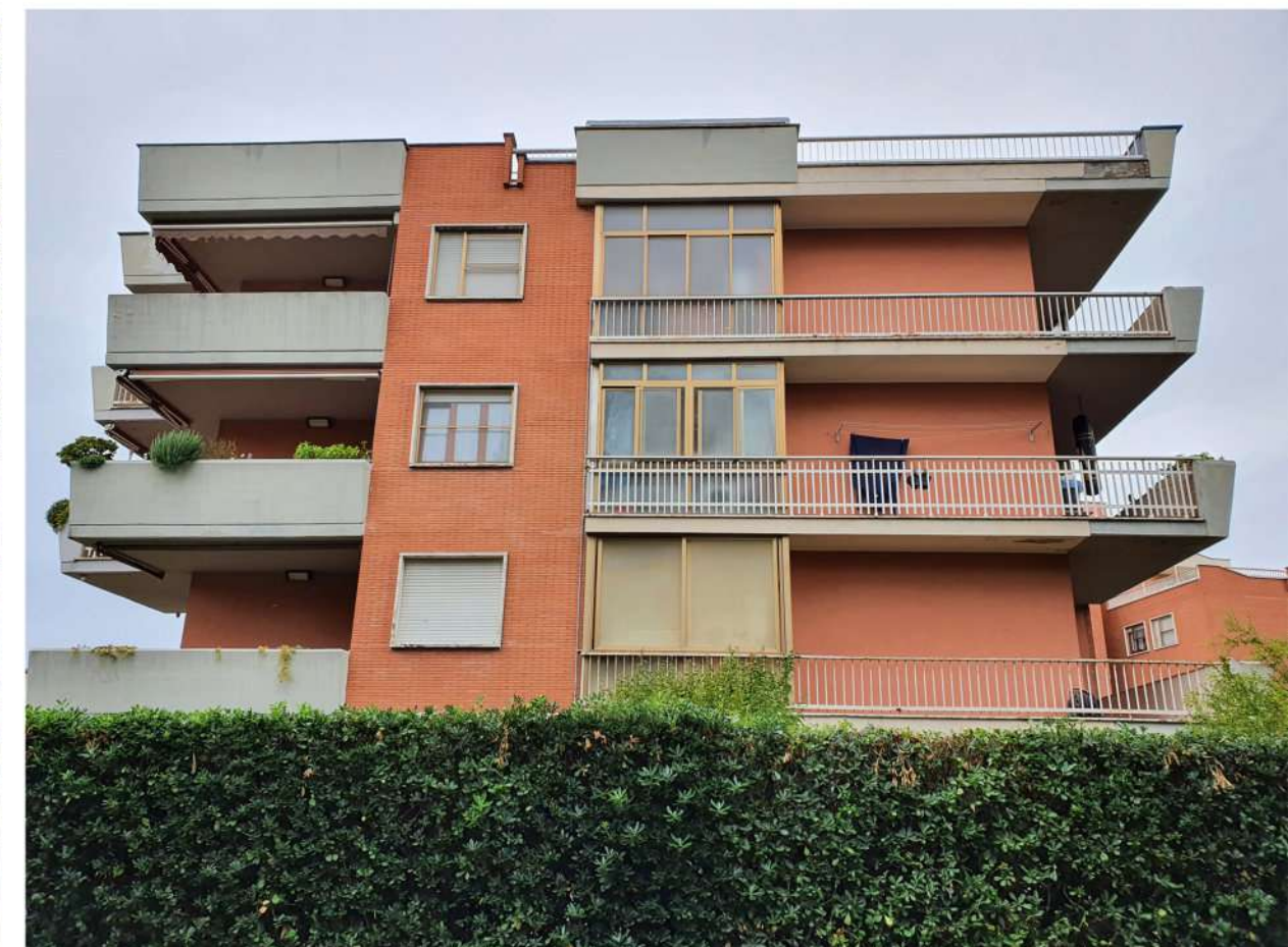
Condominio Cerveteri ex ante intervento
