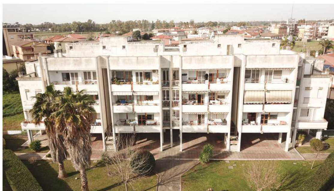
Condominio C.E.E.P.L.A. ex ante intervento
