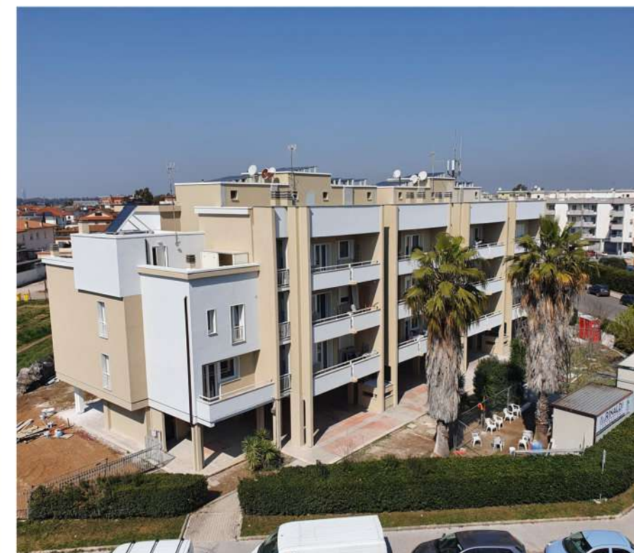
Condominio C.E.E.P.L.A. a seguito dei lavori di efficientamento
