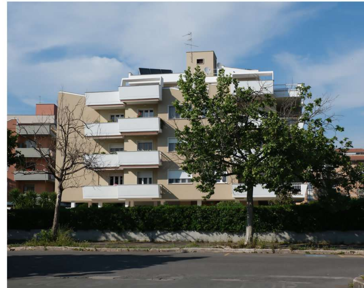
Condominio Cerveteri a seguito dei lavori di efficientamento
