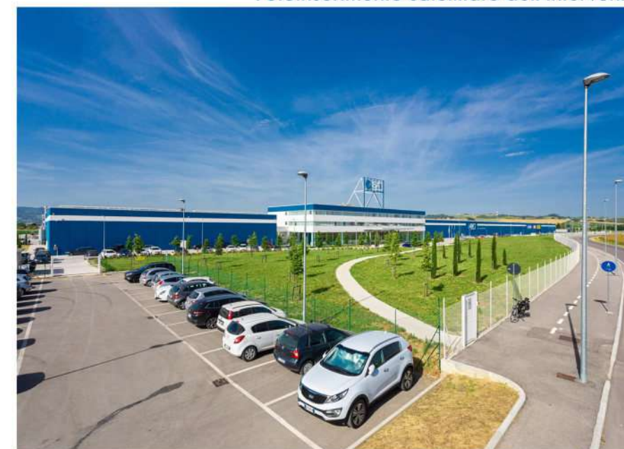
Nuovo Stabilimento realizzato
